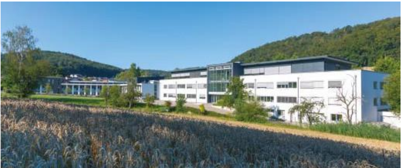
REA Elektronik GmbH 公司总部位于德国法兰克福以南 30 公里处。
